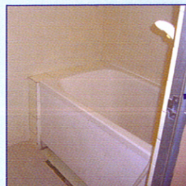
●壁面・床・タイル ↓ ●シート貼り
